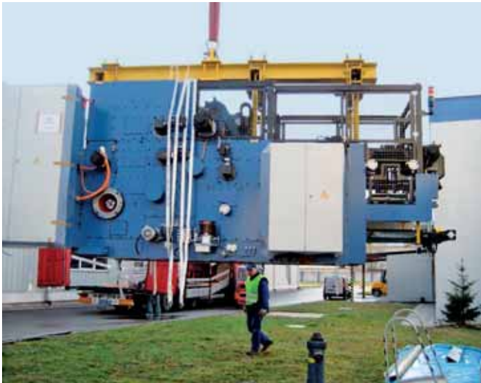
Mise en place de la plieuse KF3 C dans l'imprimerie de SCA Packaging à Pardubice
